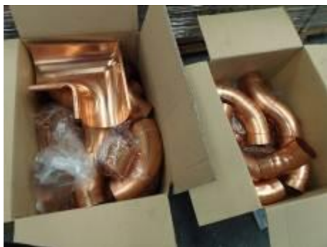
Apertura de los suministros de las canales, bajantes pluviales de cobre y sus accesorios
