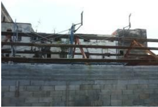
Ejecución parcial de la estructura metálica del techo a dos aguas de la parte izquierda del inmueble.
