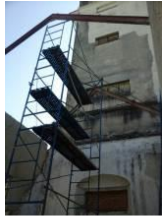
Ejecución parcial de la estructura metálica del techo a dos aguas de la parte izquierda del inmueble.
