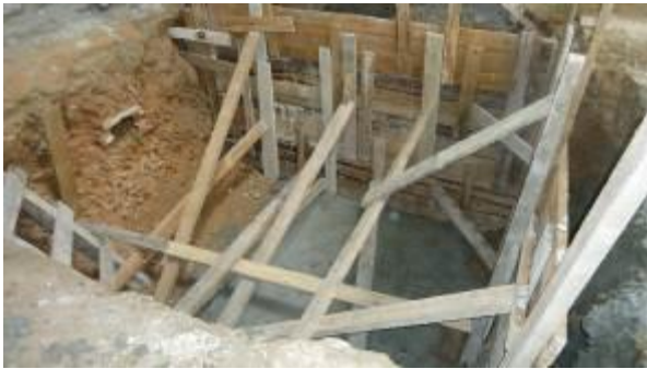
Ejecución de la excavación y losa del foso del elevador
