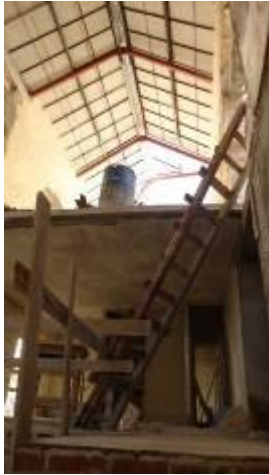
Colocación de impermeabilizante y bajo teja en techo a dos aguas de la parte delantera del inmueble.
