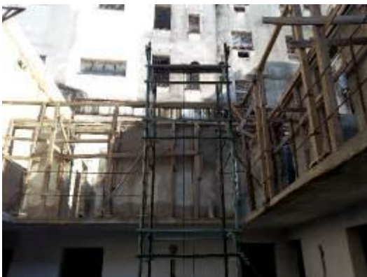
Encofrado parcial para hormigonar losa de entrepiso, vigas y columnas para colocación de vigueta y bovedilla en el nivel +10.80m
