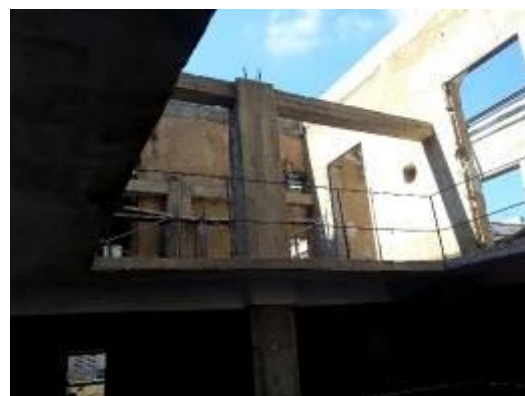
Encofrado parcial para hormigonar losa de entrepiso, vigas y columnas para colocación de vigueta y bovedilla en el nivel +10.80m
