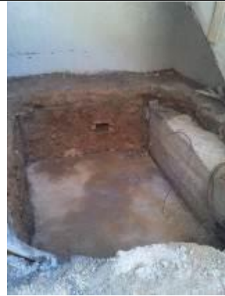
Ejecución de la excavación y losa del foso del elevador
