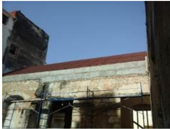
Colocación de impermeabilizante y bajo teja en techo a dos aguas de la parte delantera del inmueble.
