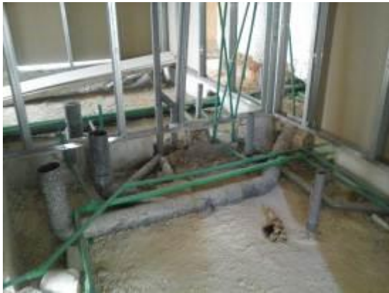
Instalaciones hidráulicas y sanitarias del nivel +4.85 m
